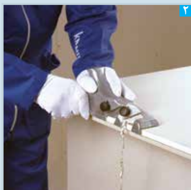
اجرای پخ با پخ زن
