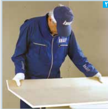
شکستن پنل در محل برش
