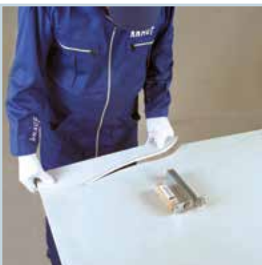
اجرای برش موج دار با دستگاه برش قرقره ای
