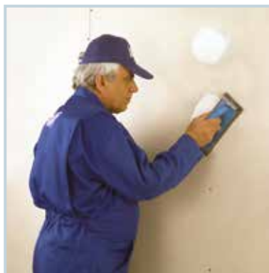
پرداخت سطح بتونه خشک
