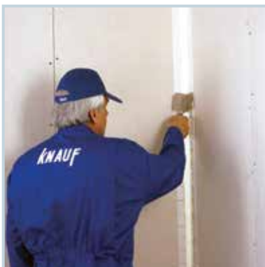
تثبیت و شکل دهی نوار درزگیر با کاردک زاویه داخلی
