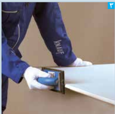
پرداخت وجه عمودی لبه پخ خورده با ساب ماله ای
