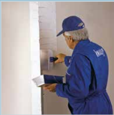
اجرای بتونه بر روی سازه محافظ گوشه
