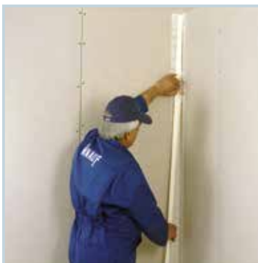
قرار دادن نوار درزگیر بر روی بتونه
