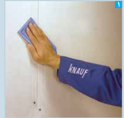
۱ تمیز کردن سطح، قبل از بتونه کاری و یا اجرای ماستیک بسیار مهم است
