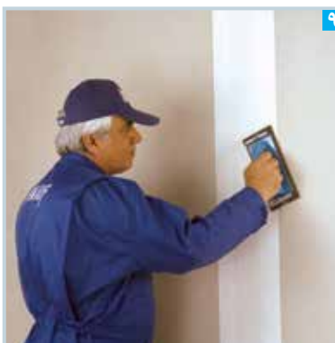
پرداخت سطح بتونه خشک با ساب ماله ای
