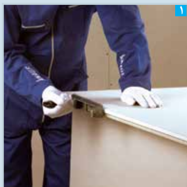
پرداخت لبه برش خورده با رنده
