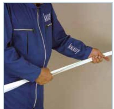
خم کردن نوار درزگیر با دست
