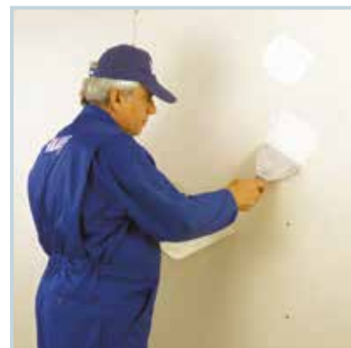
اجرای بتونه در محل پیچ‌ها
