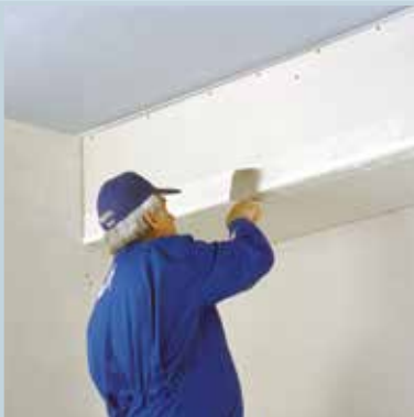
تثبیت و شکل دهی نوار درزگیر با کاردک زاویه خارجی
