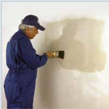
اجرای لایه پرایمر بر روی ماستیک، قبل از رنگ آمیزی با رنگ روغنی
