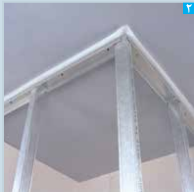
شکل نوار چسب جداکننده، پس از نصب سازه‌ها
