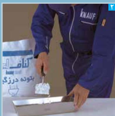
ریختن پودر بتونه در آب
