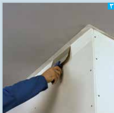
بتونه کاری در فصل مشترک دیوار خشک و سقف بنایی
