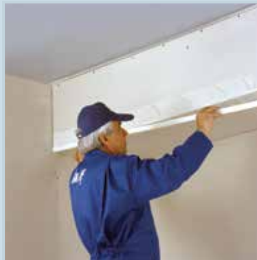
قرار دادن نوار درزگیر بر روی بتونه
