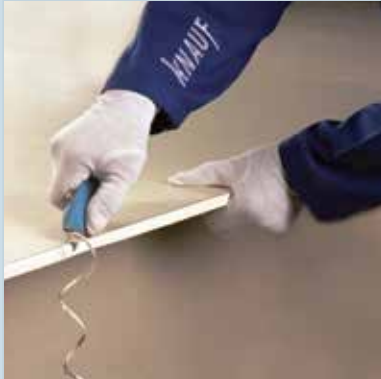
اجرای پخ با تیغ برش
