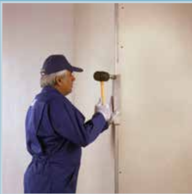
نصب سازه محافظ گوشه، با دستگاه کرنبرید کوب
