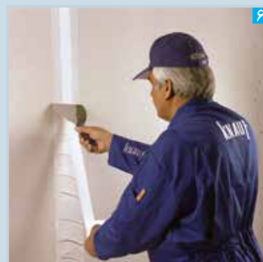
قرار دادن نوار درزگیر بر روی بتونه
