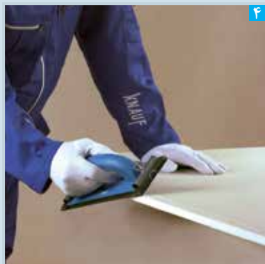
پرداخت وجه مایل لبه پخ خورده با ساب ماله ای
