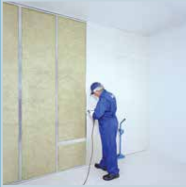
نصب پنل بر روی زیرسازی، با استفاده از جک و پیچ زن
