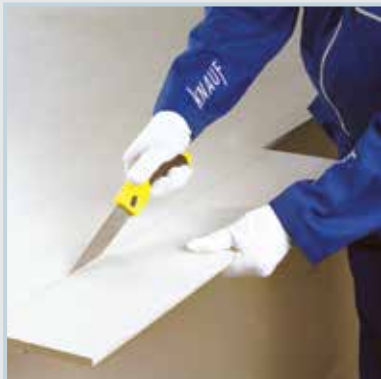
برش پنل با اره دستی
