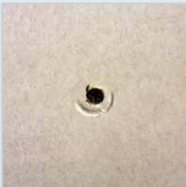
پیچی که به صورت مایل اجرا شده و به کاغذ روکش پنل آسیب رسانده است
