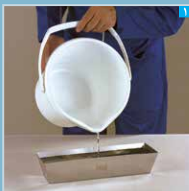
ریختن آب در ظرف تهیه بتونه
