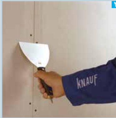
۲ بررسی بیرون زدگی پیچ ها با کاردک
